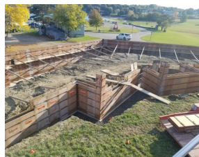
Preparing to pour foundation walls
